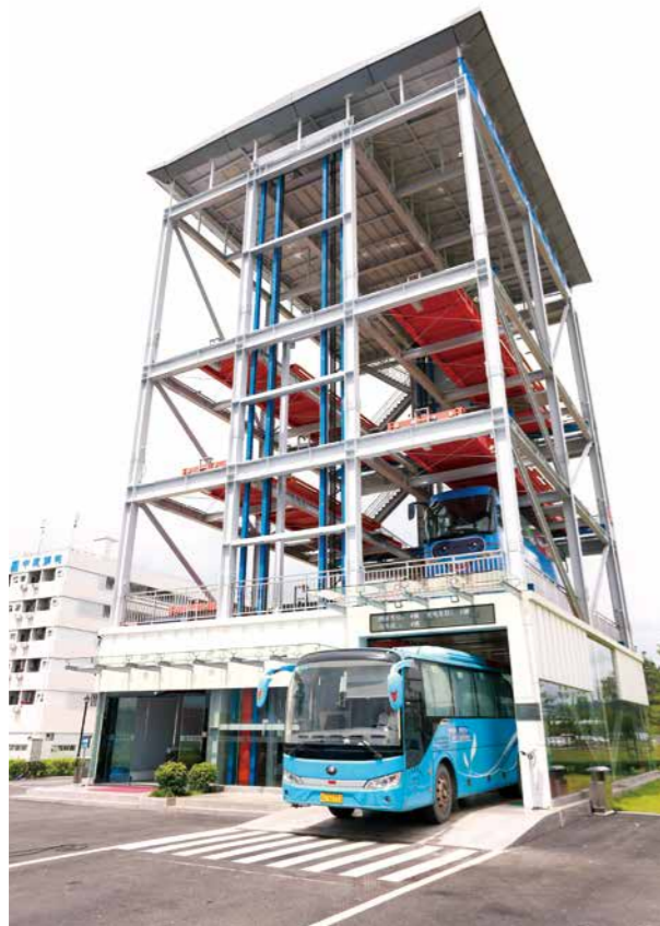
全国首个基于5G的新能源公交立体车库。
