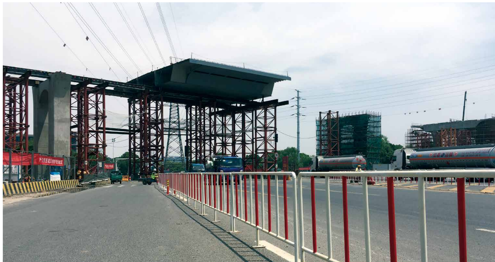
钢箱梁高空滑移施工现场。
