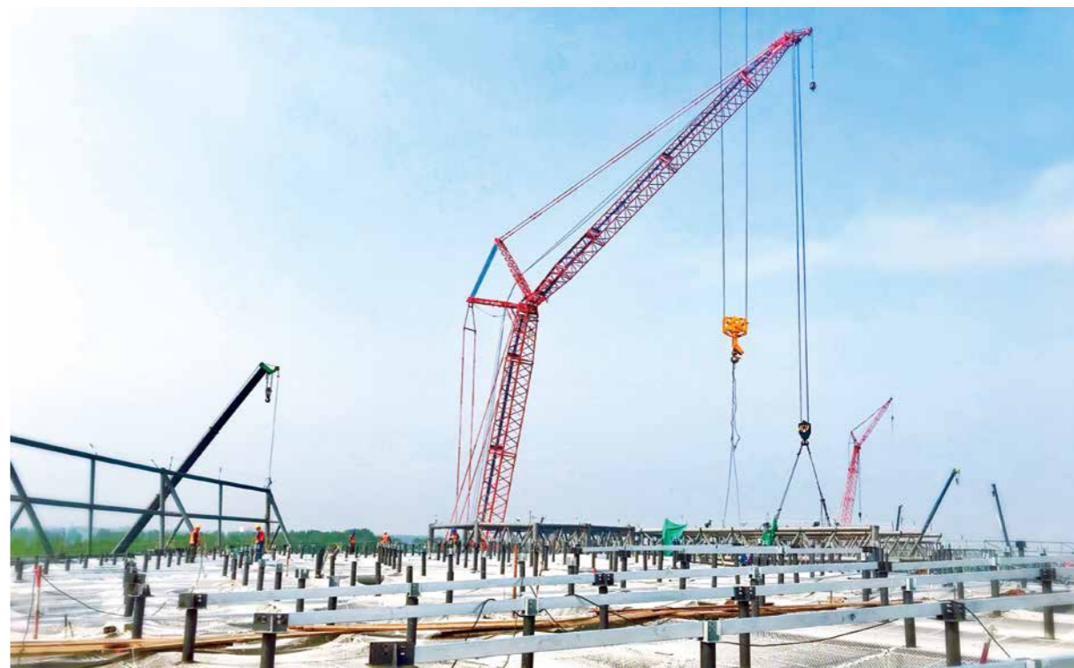
项目钢结构施工中。
