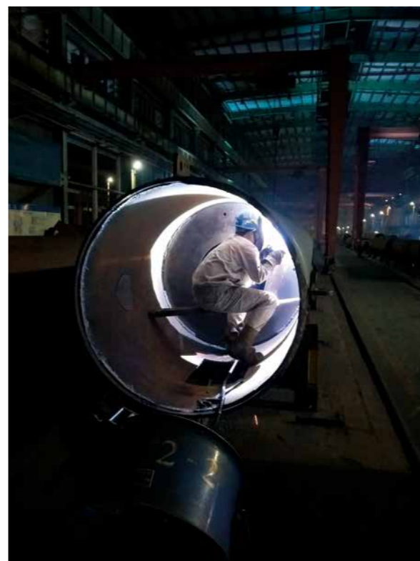
武汉厂焊接工人夜间焊接施工。
