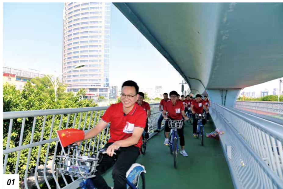
01/ 福建分公司组织员工在公司承建的厦门空中自行车道上开展“十一周年·十一公里”司庆健康骑行活动 摄影：王启涛 福建分公司
