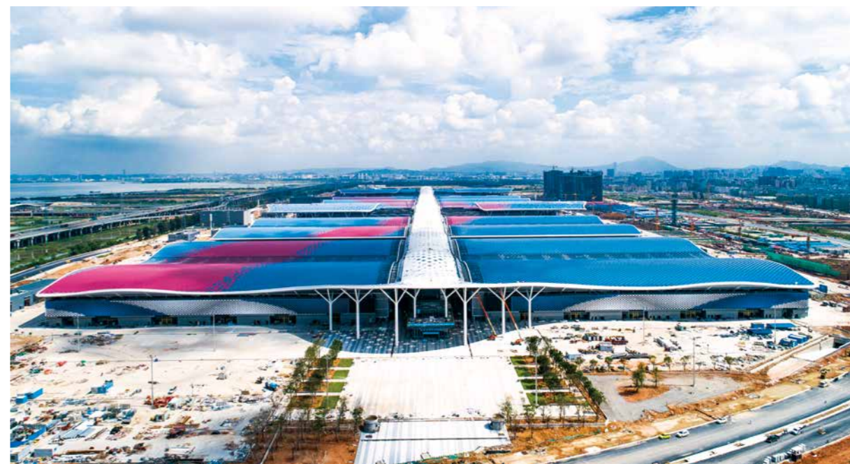
深圳国际会展中心实景航拍。
