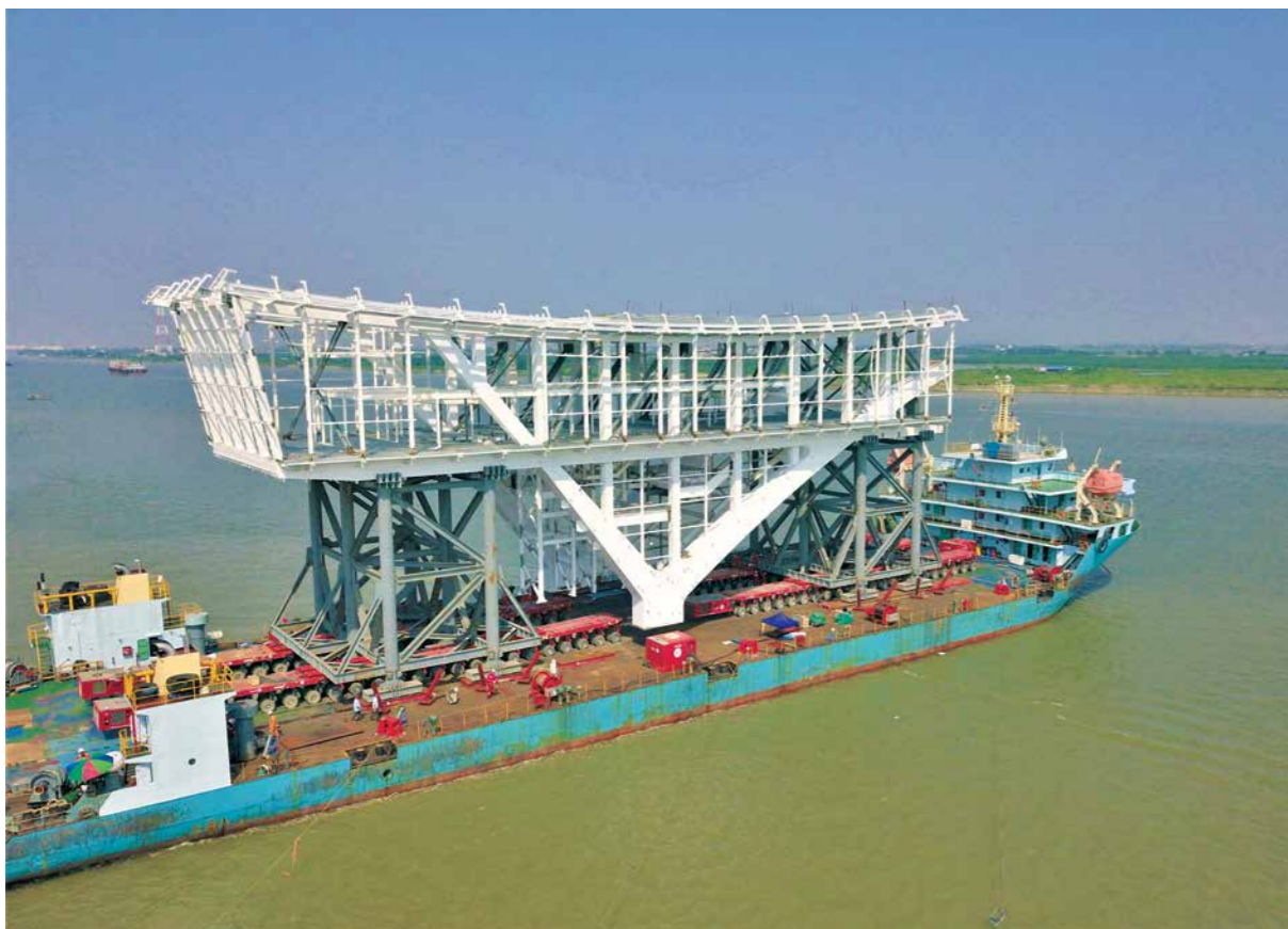
中建钢构承建的香港机场天桥项目首段构件发运。
