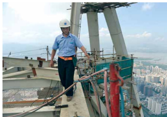
2015年，深圳平安金融中心项目顶部施工检查。
