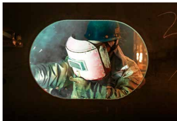
李顺周在箱体构件里焊接。
