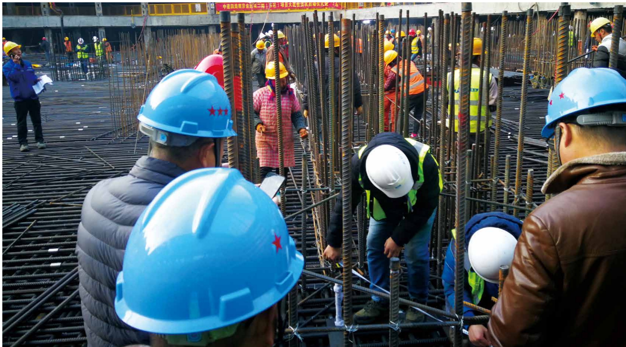
项目施工现场如火如荼。
