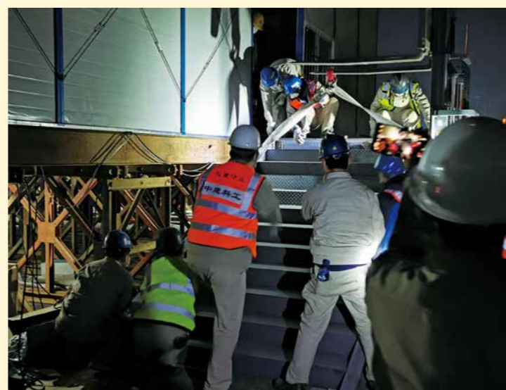
深夜，依然奋战在雷神山现场安装一线。
