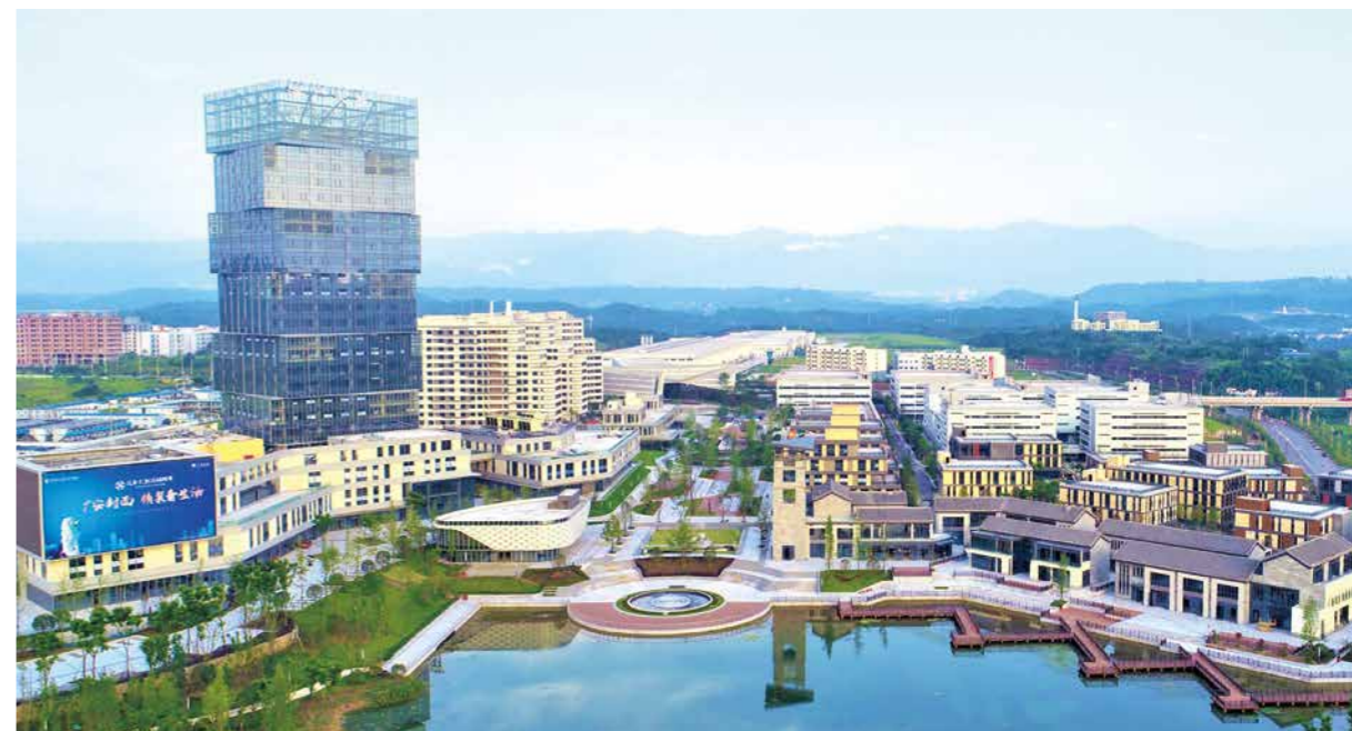
深广·渠江云谷产业园实景图。
