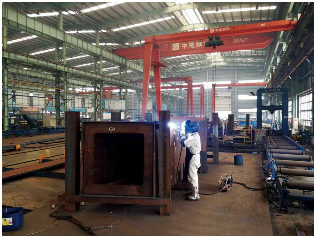
武汉光谷“星河”雕塑飘带型龙骨弯扭型主体焊缝焊接。
