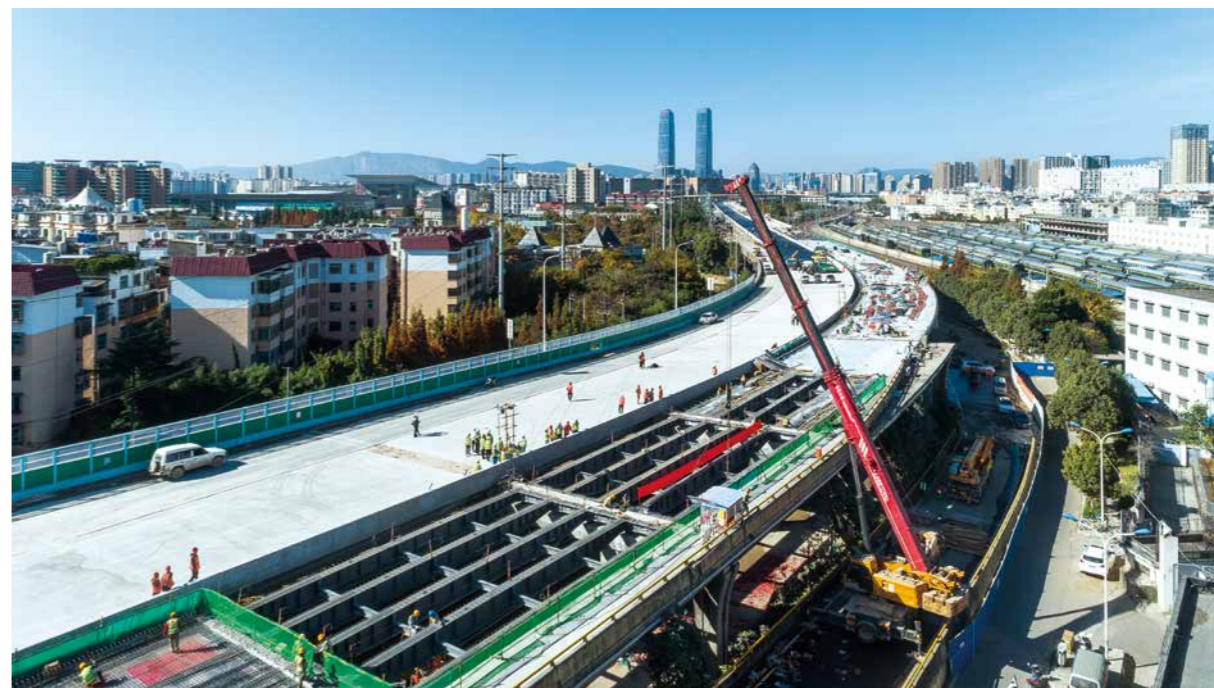
公司昆明南二环提升改造工程实现合龙。
