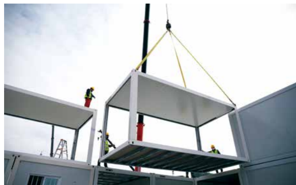
深圳应急医院项目箱体吊装
