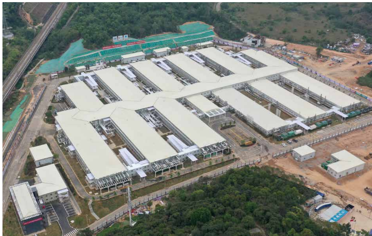
深圳市第三人民医院二期工程应急院区项目航拍图。
