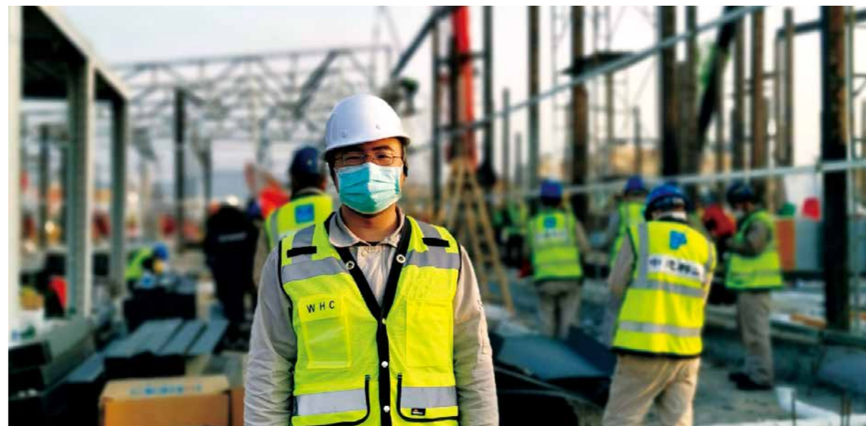
么忠孝在火神山项目一线，支援现场钢梁焊接安装。
