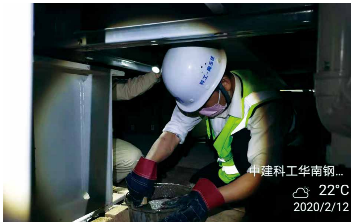
灌水泥固定钢结构墩。
