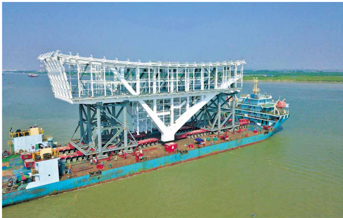
拼装钢构件进行海运。
