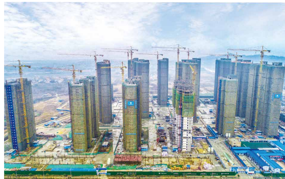
华中大区蔡甸经济开发区泰山街产城融合示范区一期项目复工。
