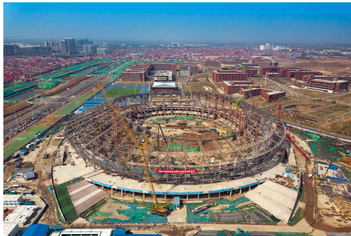
邯郸市体育中心主体结构封顶。
