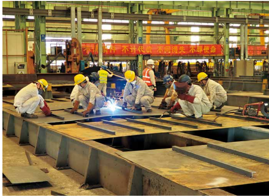
华南钢结构公司复工复产 摄影：张德修 华南钢结构公司
