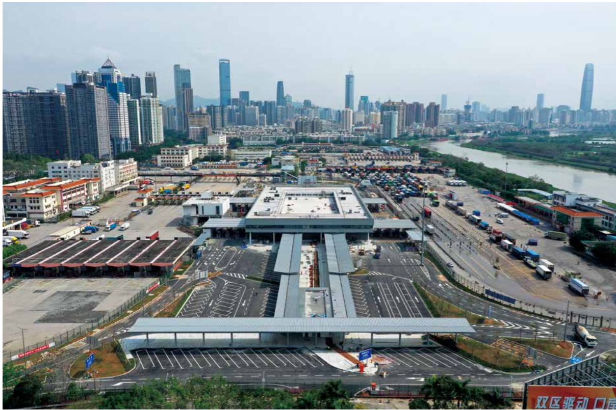
深圳皇岗口岸临时旅检场地建设工程项目航拍。
