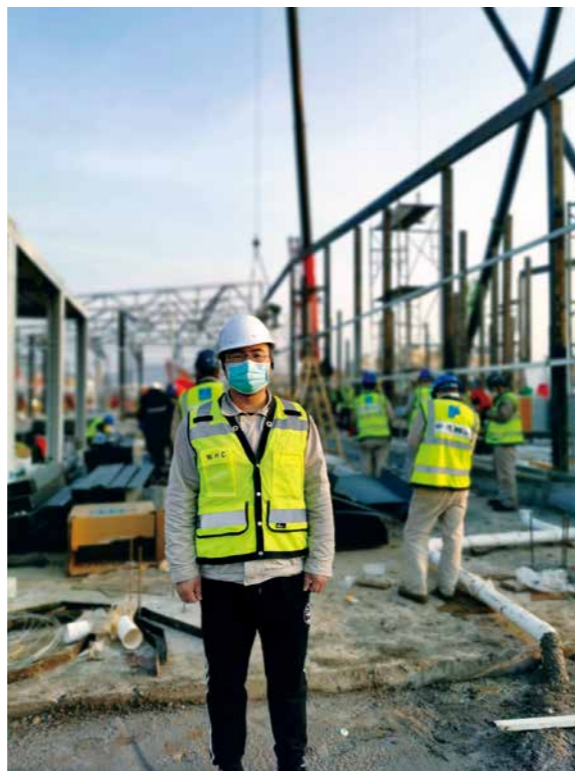
么忠孝在火神山项目一线，支援现场钢梁焊接安装。
