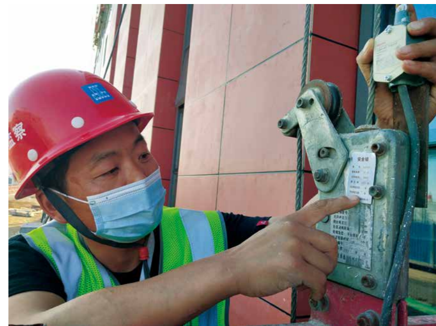
任丰岑现场检查设备安全。
