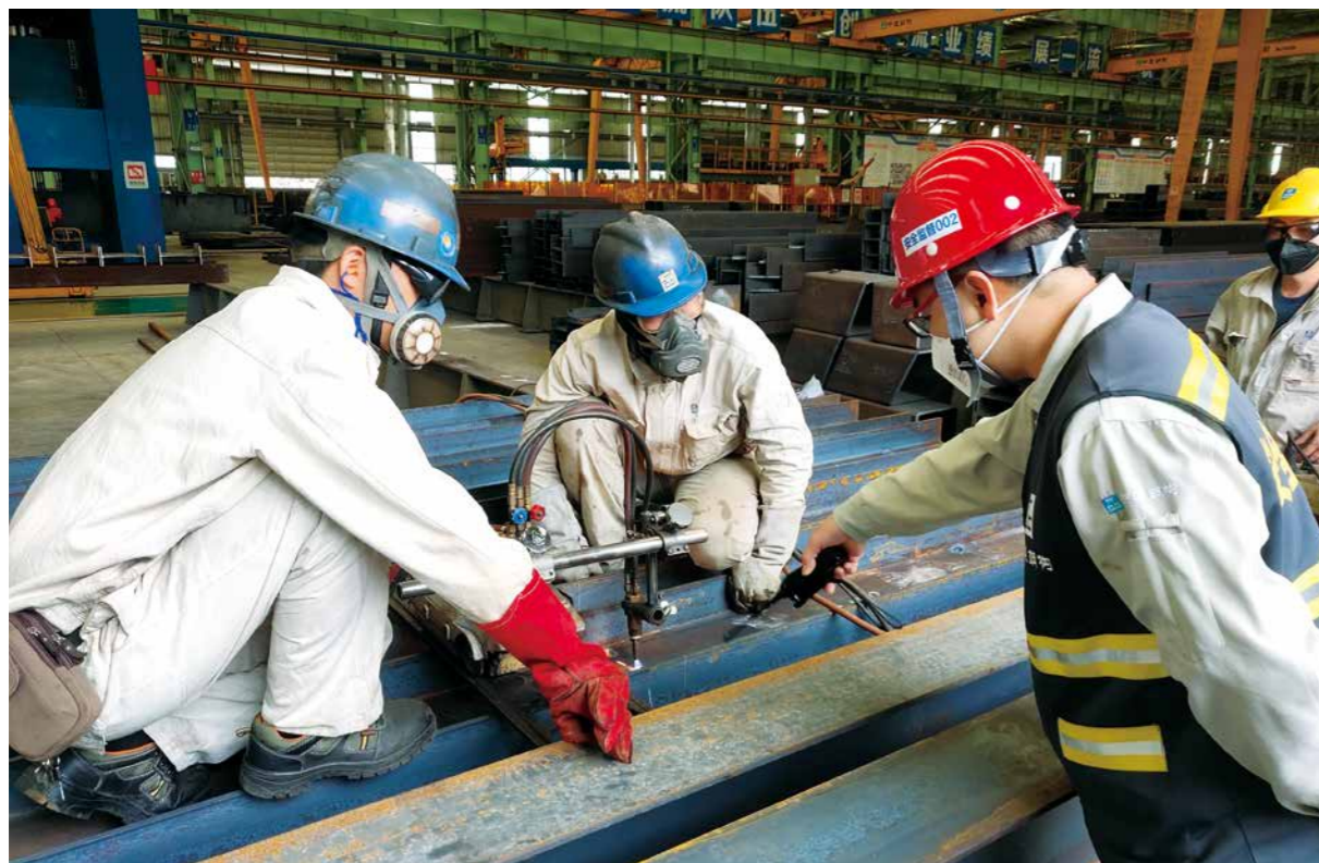
黄国新（右二）现场检查工人作业情况。
