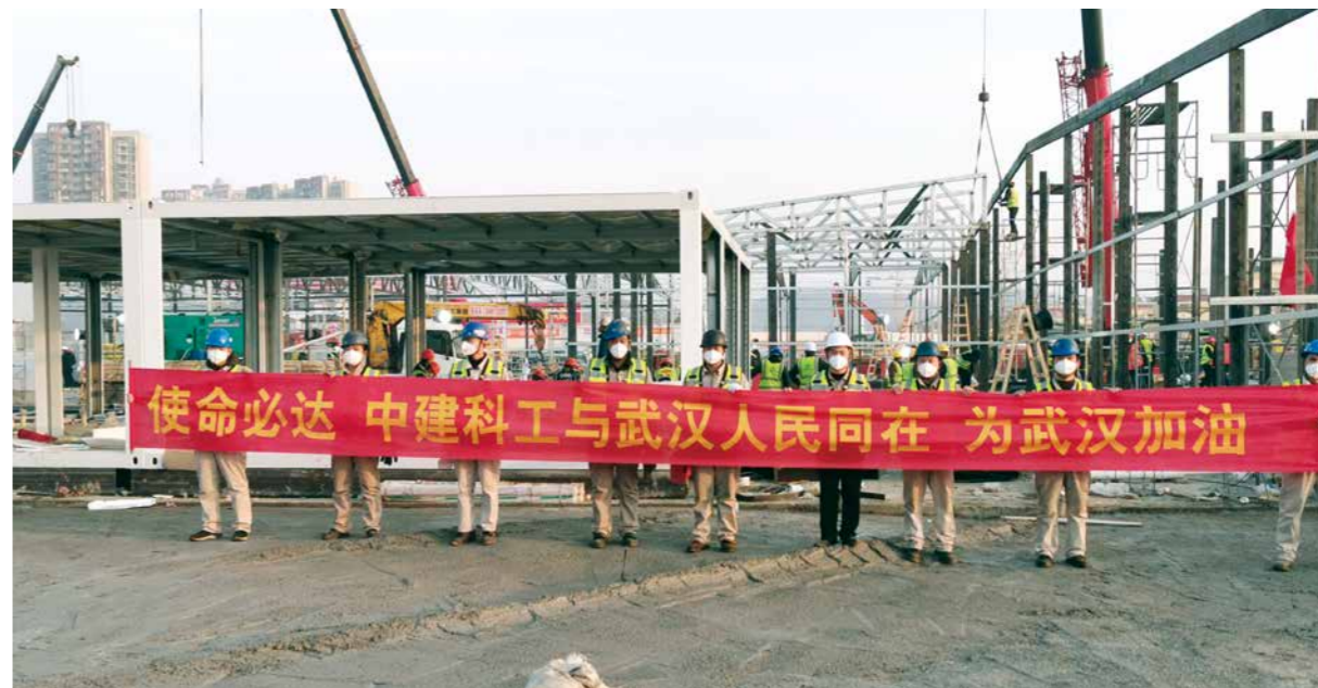
么忠孝和工友一起奔赴火神山医院进行钢梁、门框焊接安装。
