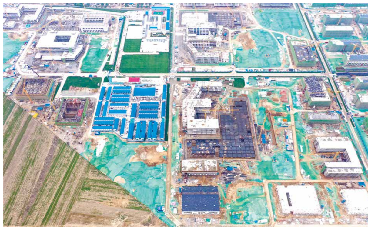
中建科工石家庄信工学院项目航拍。
